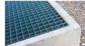
2 Durch eine **Erhöhung** der Lichtschachtoberkanten kann Wassereintritt verhindert werden. Diese Maßnahme ist auch noch nachträglich umsetzbar.
