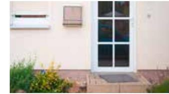
1 Das Wasser kann über Türen eindringen. Dies kann z. B. durch erhöhte Hauseingänge mit **Stufen** verhindert werden.
