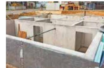
5 Bei Neubauten wird durch den Einsatz von wasserundurchlässigem Beton (Weiße Wanne) der Kellerbereich u. a. gegen drückendes Grundwasser geschützt.
