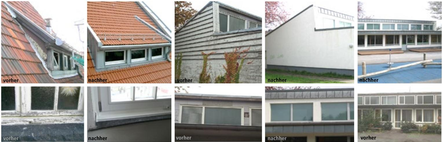
**Schadstoffsanierung:** Entfernung künstlicher Mineralfaser, Entfernung von PCB in Tür- und Fensterdichtungen so wie Asbestsanierungen (Realisierungszeitraum ab 2003). Es bestand kein eigenes Budget, die Mittelbereitstellung erfolgte aus Bauunterhaltungs-, Schulreparatur- und Brandschutzmitteln.
