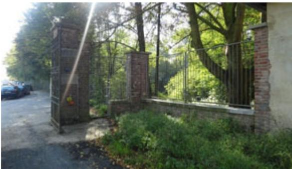
Abb. 68 Neu eingefügte Stahlgitterelemente seitlich des historischen gusseisernen Eingangstores
