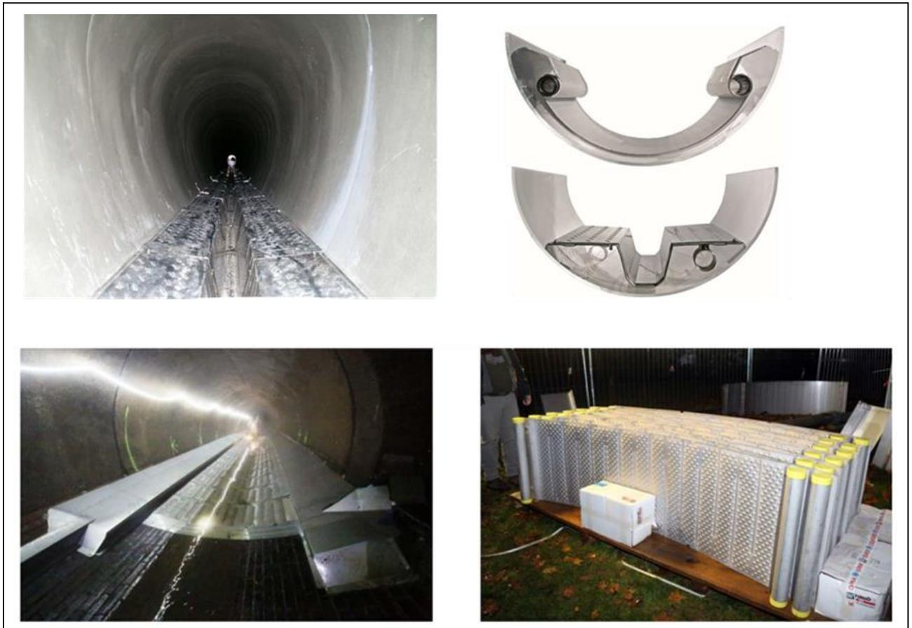
Abbildung 60: Abwasserwärmetauscher (Bildquelle: Fa. Uhrig (oben), Stadtwerke Aachen (unten))
